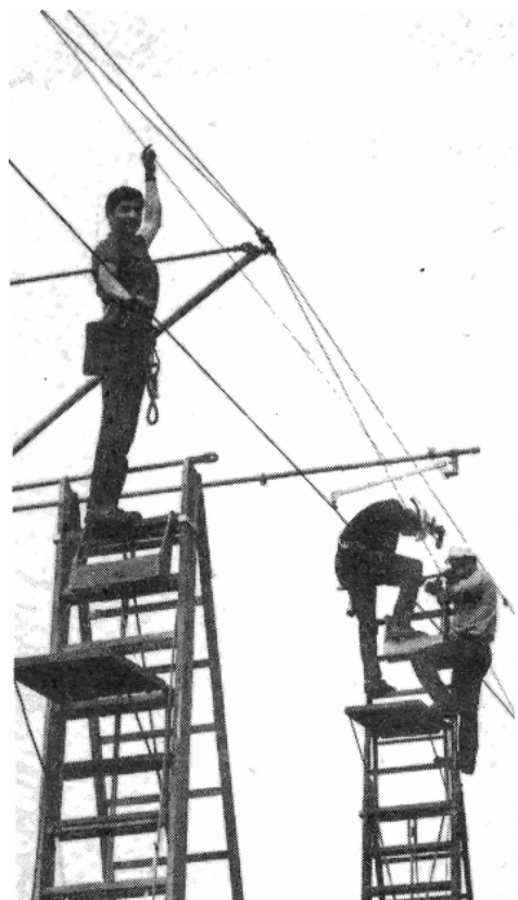
Zwischen Himmel und Erde, auf den schmalen Plattformen der Leitern stehend, arbeiten Monteure an den Leitungen.
